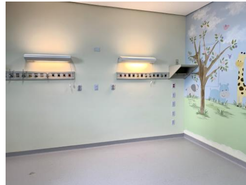
Figura 23: Reforma da UTI-Pediátrica
