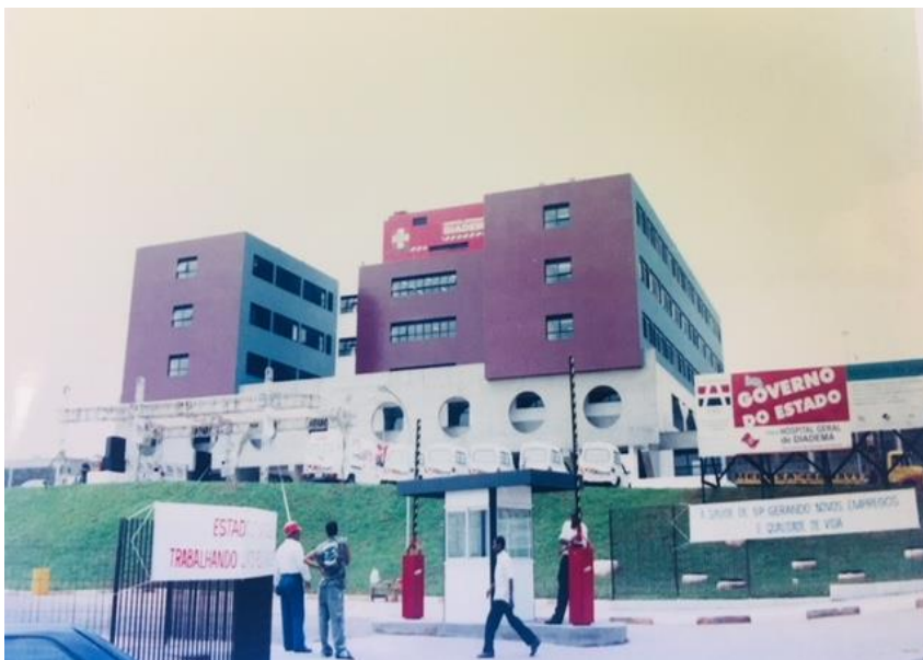
Figura 1- Hospital Estadual de Diadema no término de sua construção no ano de 2000.
